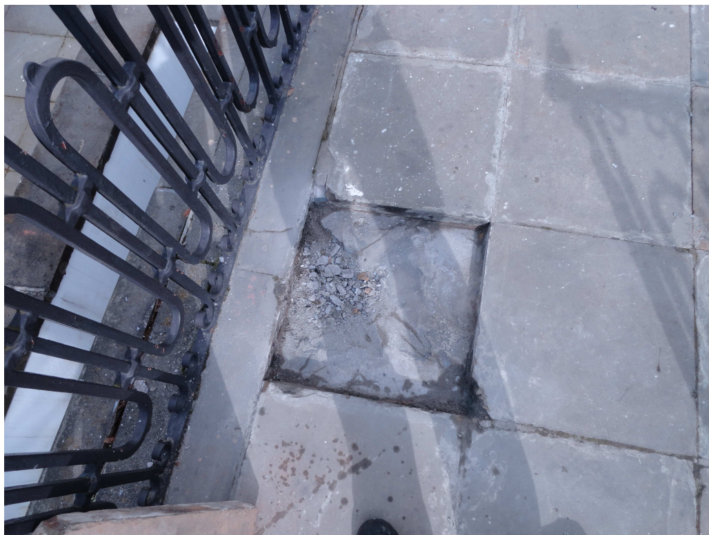
Fot. nr 14 Odkrywka w tarasie zasadniczym.
