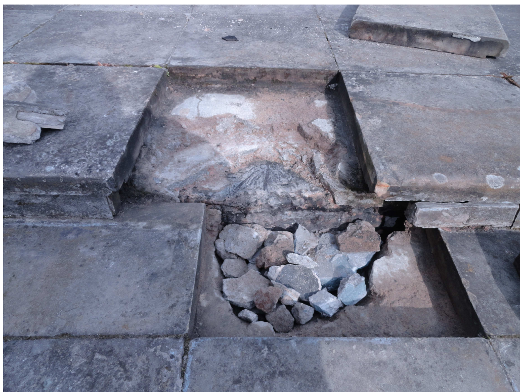
Fot. nr 15. Odkrywka w tarasie nad kuchnią. Widoczna blacha ołowiana.
