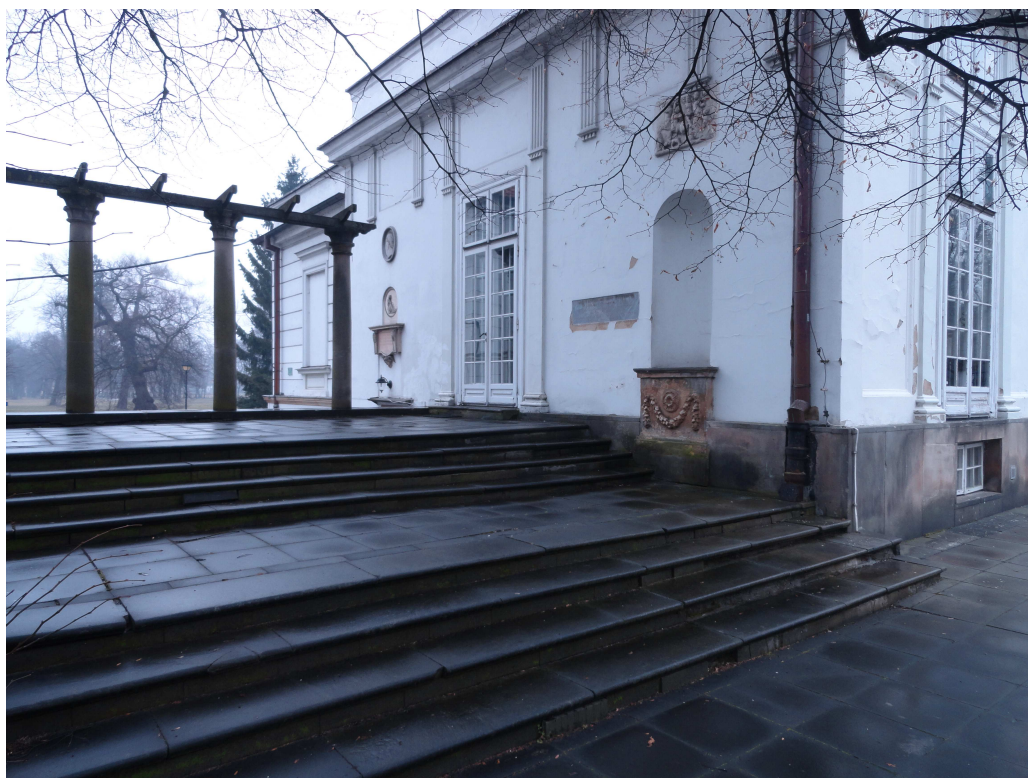
Fot. nr 9 Taras ziemny od strony północnej.
