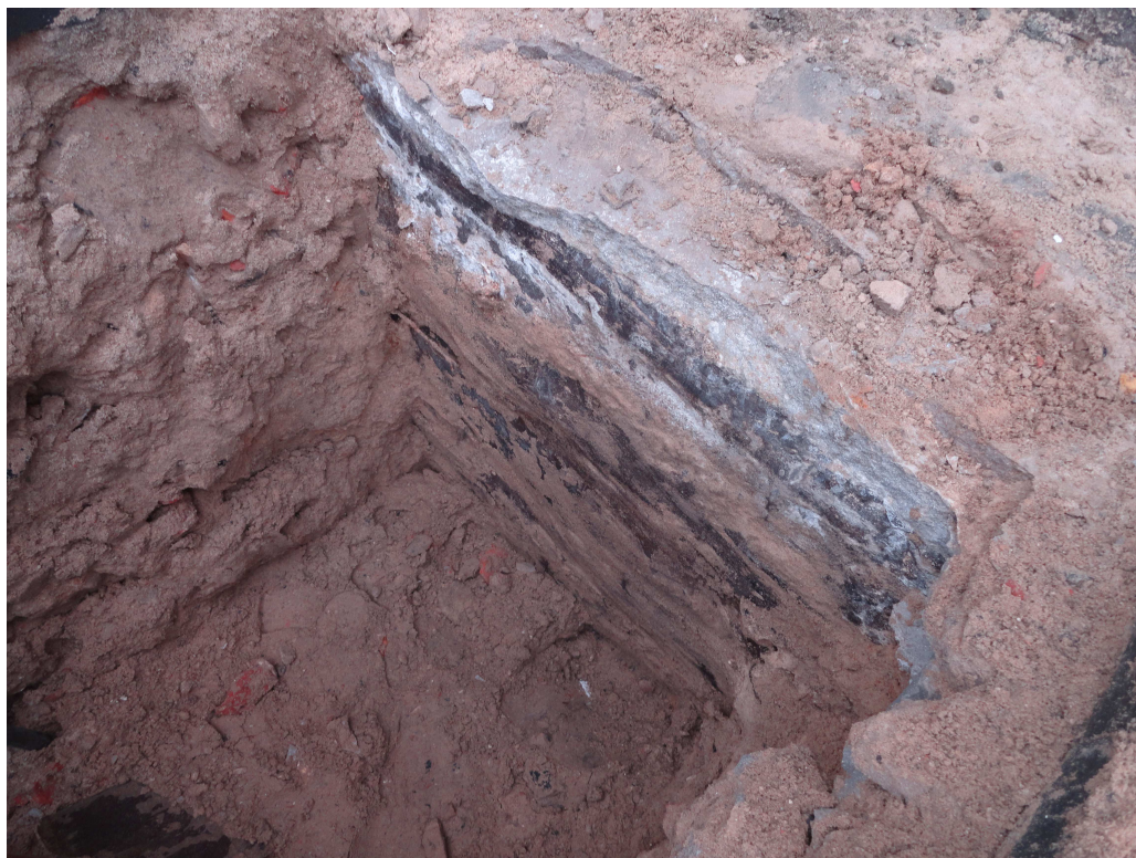
Fot. nr 3 Odkrywka ściany piwnicznej - widoczna tarcza betonowa.
