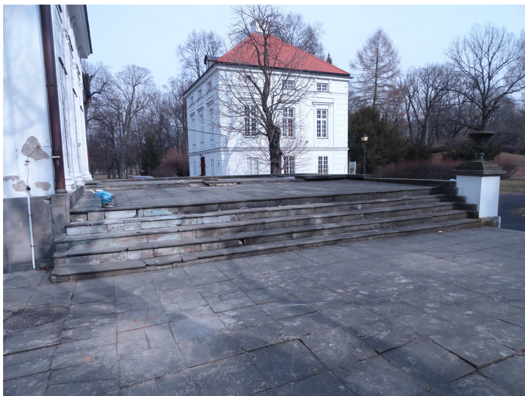
Fot. nr 10 Taras nad kuchnią.
