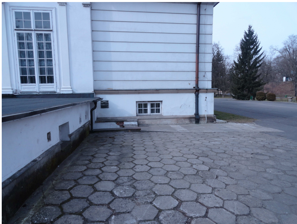
Fot. nr 5 Utwardzony kostką betonową plac przed kuchnią. Widoczny kamienny cokół pałacu.
