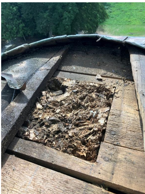
Fot. 4. Odkrywanie wierzchu kuli, widoczny spróchniały drewniany słup
