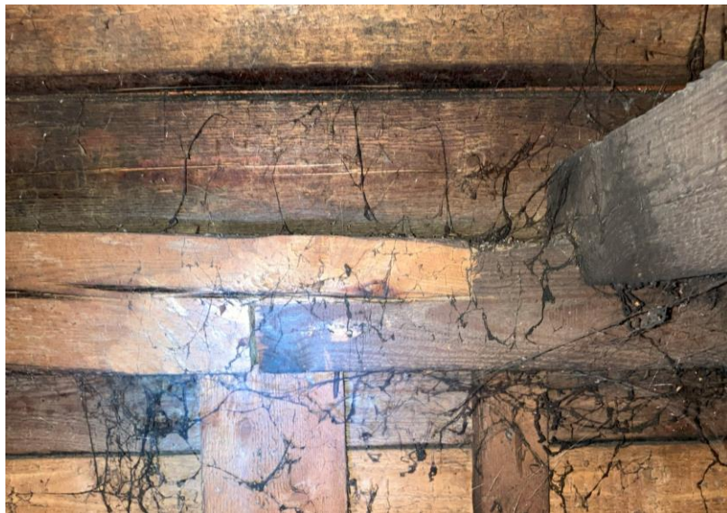
Fot. 7. Miejsce połączenia nowej konstrukcji drewnianej ze starą
