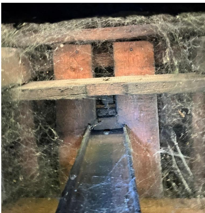
Fot. 6. Profil stalowy stanowiący obudowę słupa w szczycie dachu
