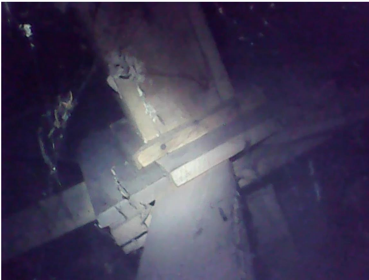
Fot. 2. Widok wnętrza kuli. Widoczna obudowa słupa oraz węzeł i deski stanowiące zamocowanie krążyn poszycia kuli.
