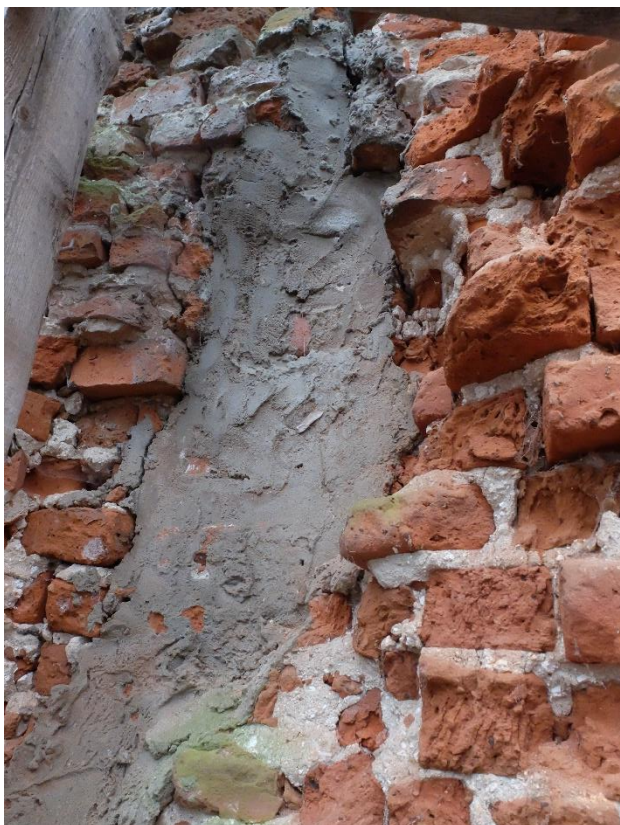
Fot. 4. Wypełnienie pęknięcia w ścianie północnej z betonu i cegły
