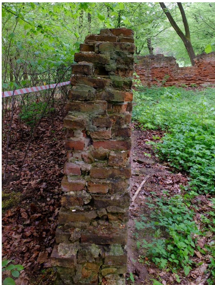
Fot. 8. Widok końca muru z widocznym nachyleniem
