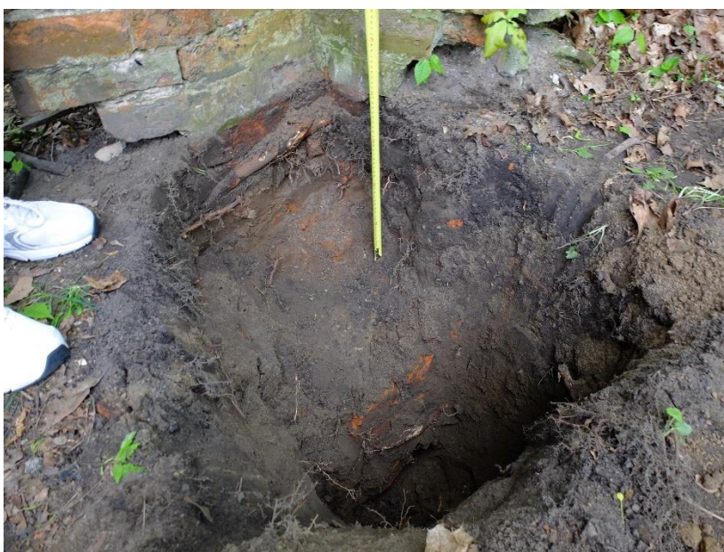
Fot. 10. Fundamenty filara przylegającego do muru. Wierzch stopu ok. 40cm poniżej terenu.
