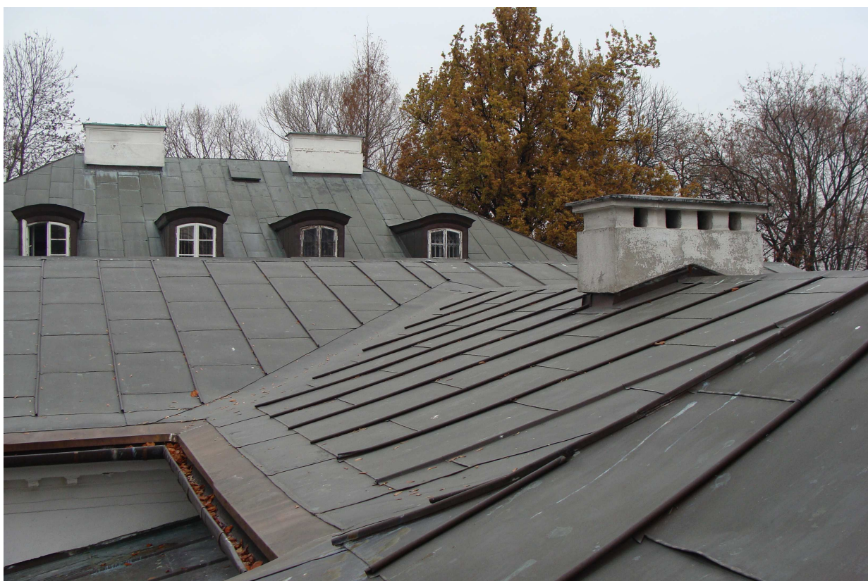
Fot. 10. Widok dachów w kierunku północnym
