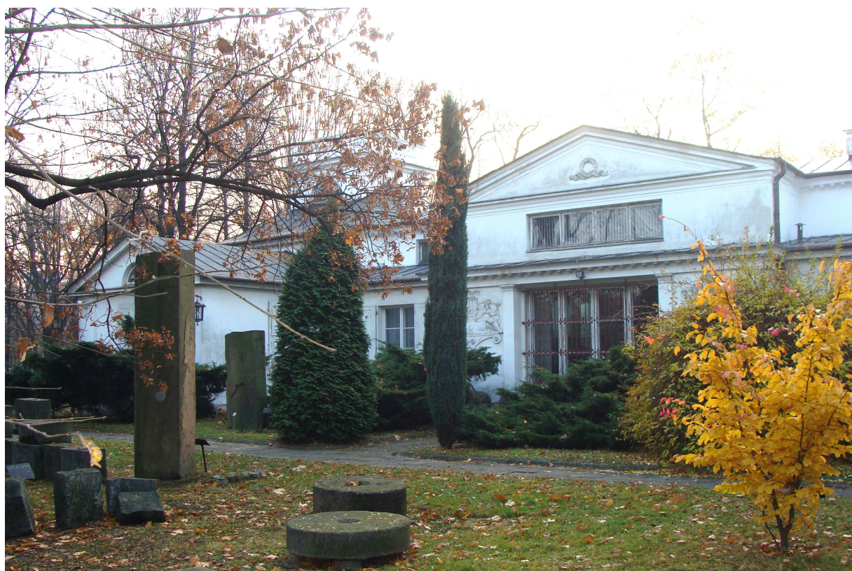
Fot. 6. Elewacja wschodnia, ogrodowa
