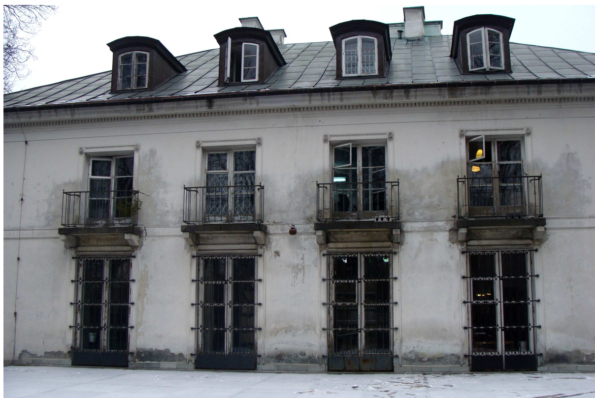
Fot. 5. Elewacja północna, boczna – część dwukondygnacyjna
