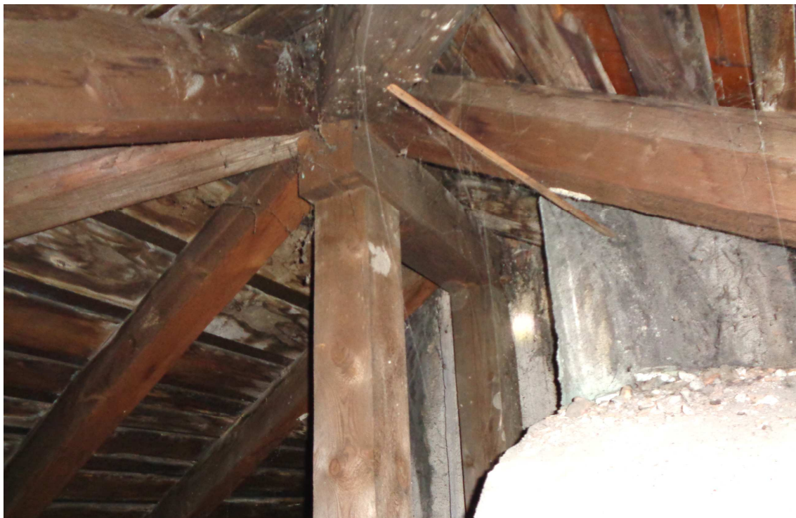
Fot. 17. Fragment więźby – widoczna płatew kalenicowa i zawilgocenia deskowania
