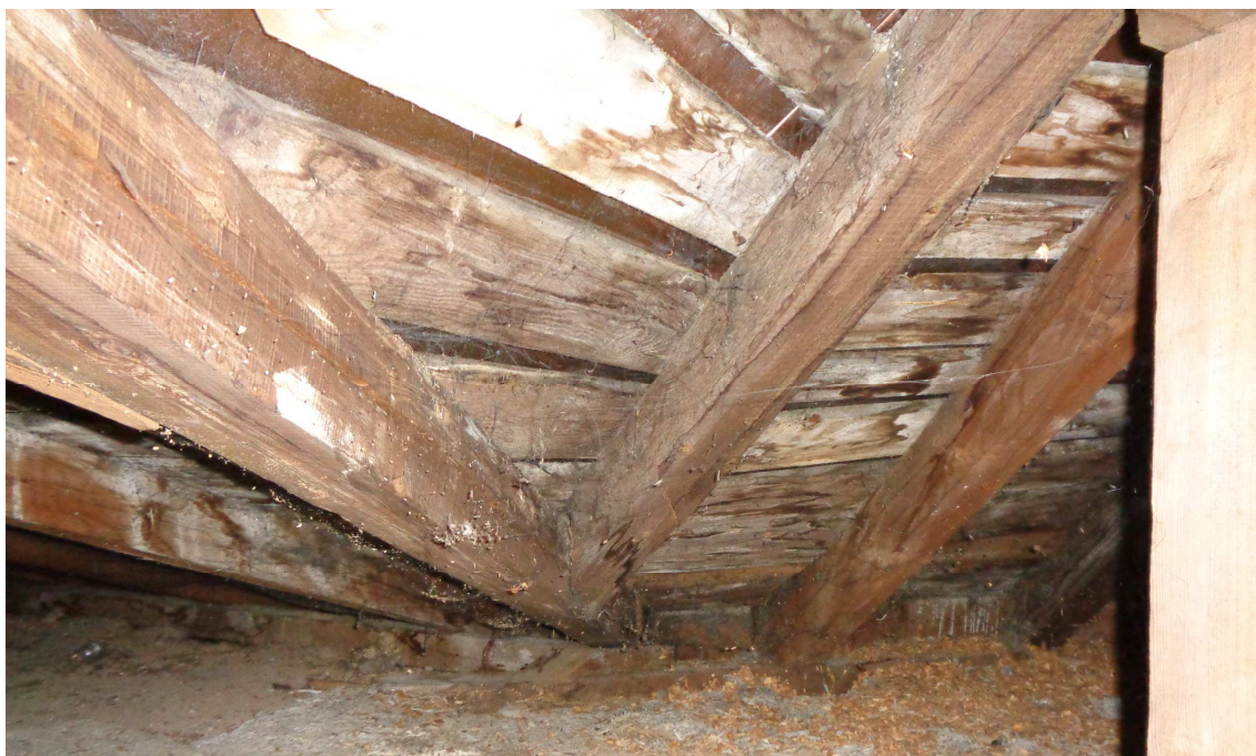
Fot. 18. Połączenie dachów D i E
