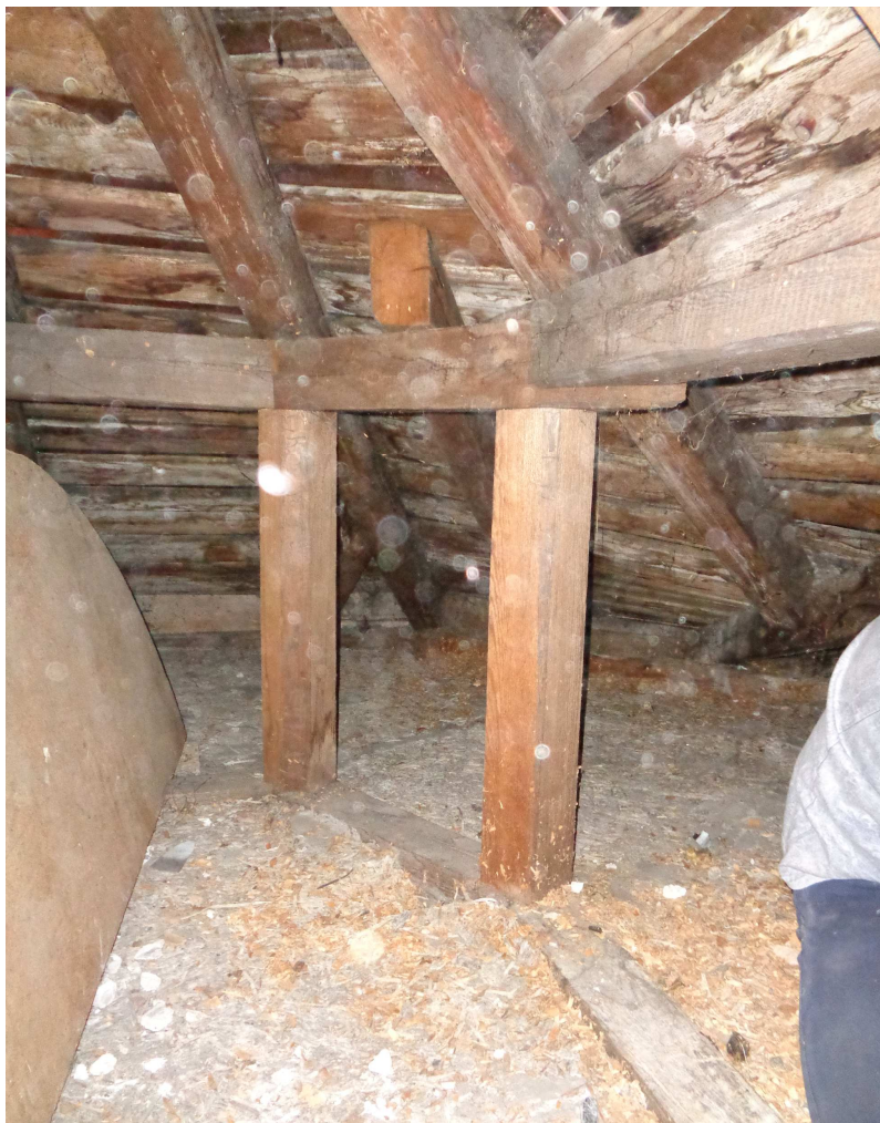
Fot. 23 i 24.. Dach E – widoczne zawilgocenia deskowania
