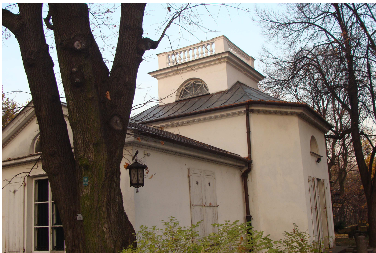
Fot. 8. Elewacja południowa
