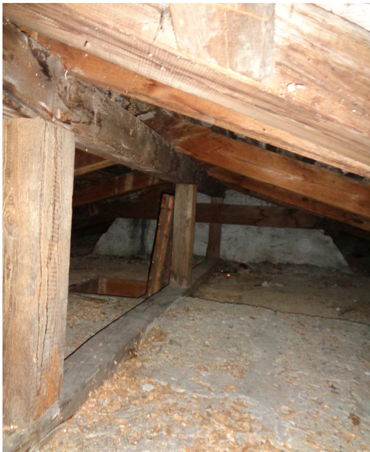
Fot. 19. Dach D – widoczne zniszczenie fragmentu krokwi kalenicowej
