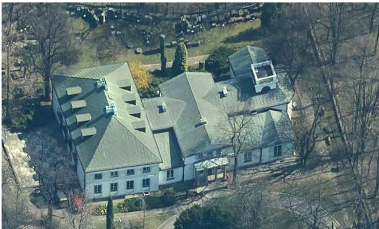
Fot. 2. Widok dachów obiektu, stan aktualny
