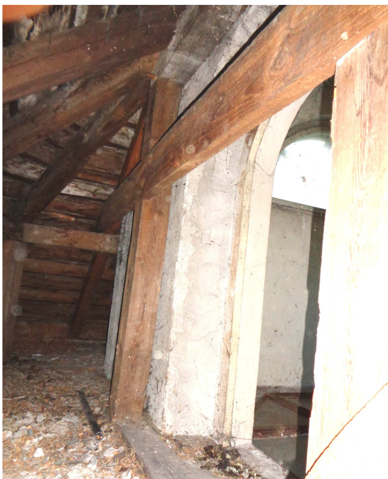
Fot. 25. Dach E – widoczne zawilgocenia deskowania
