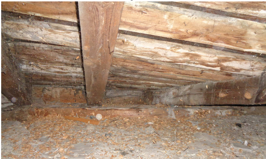
Fot. 23 i 24.. Dach E – widoczne zawilgocenia deskowania
