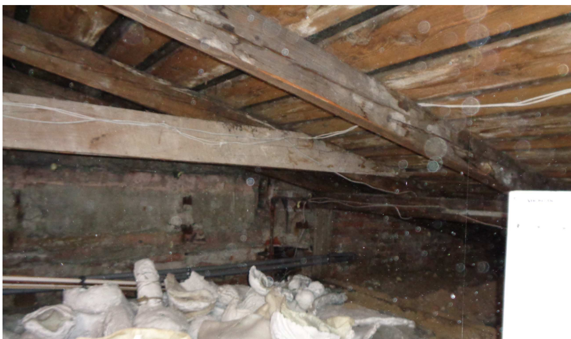
Fot. 27 i 28. Dach G – zawilgocenia deskowania i krokwi
