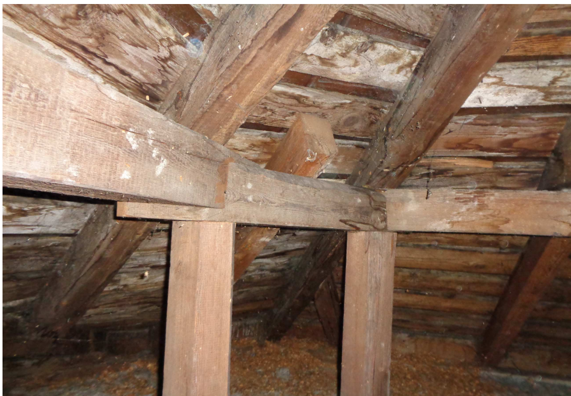
Fot. 25. Dach E – widoczne zawilgocenia deskowania
