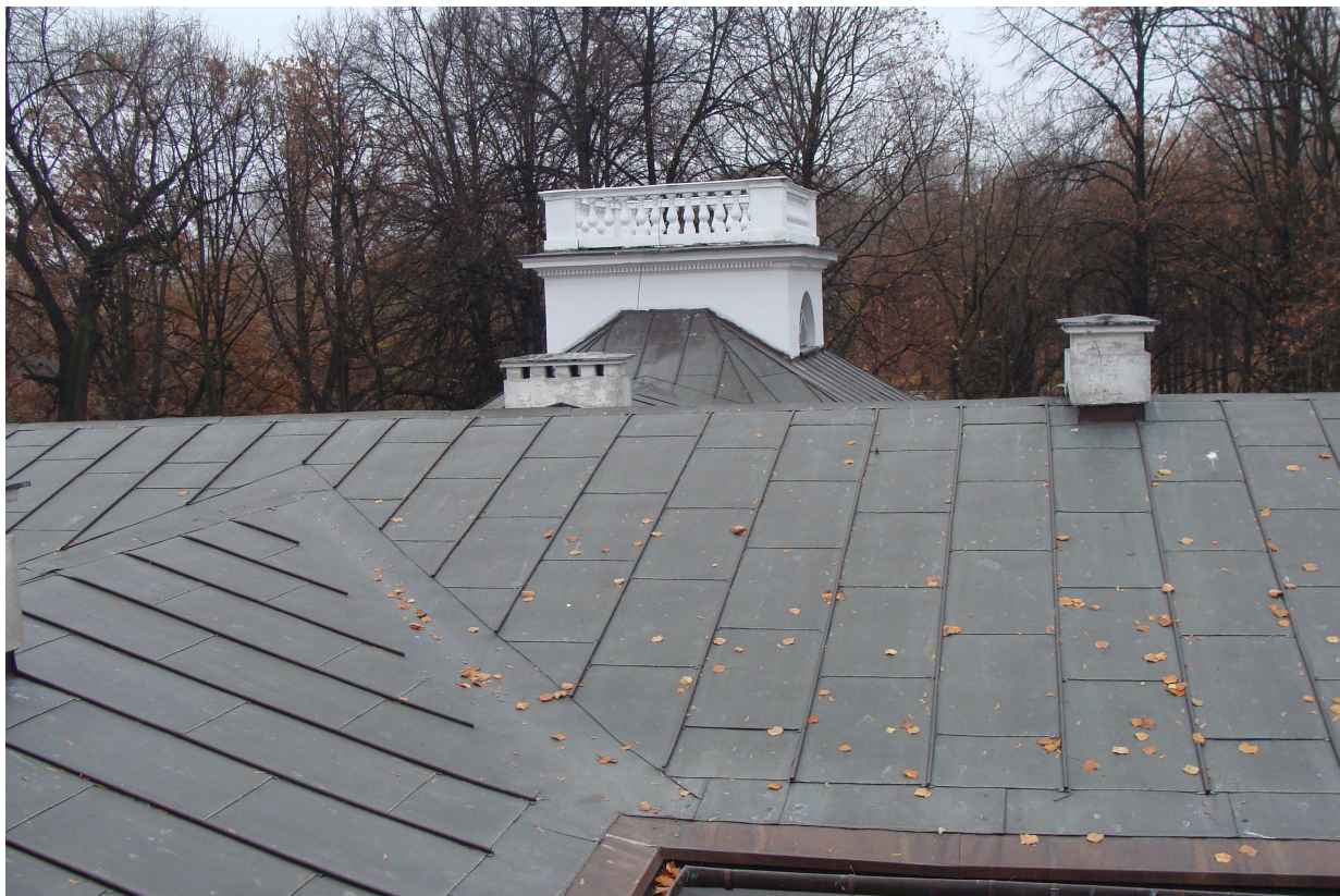
Fot. 9. Widok dachu w kierunku południowym
