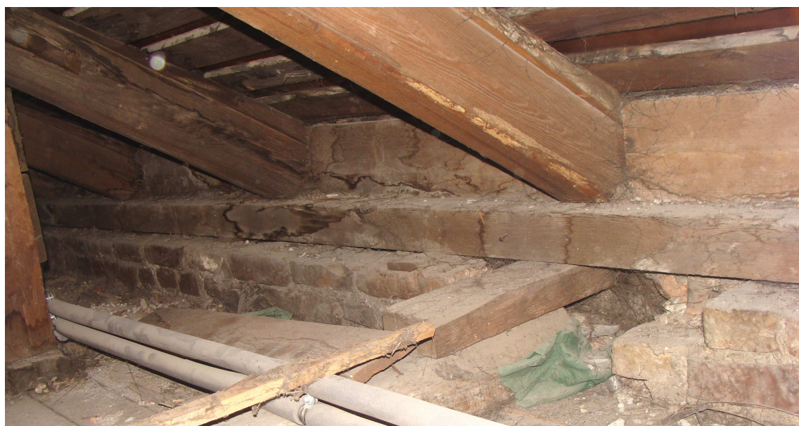
Fot. 15. Fragment więźby – część dolna
