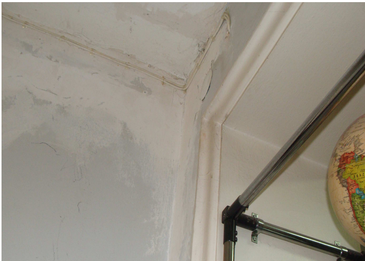
Fot. 13. Sala ekspozycyjna. Zniszczenia efektem nieuszczelności dachu i przemarzania stropu
