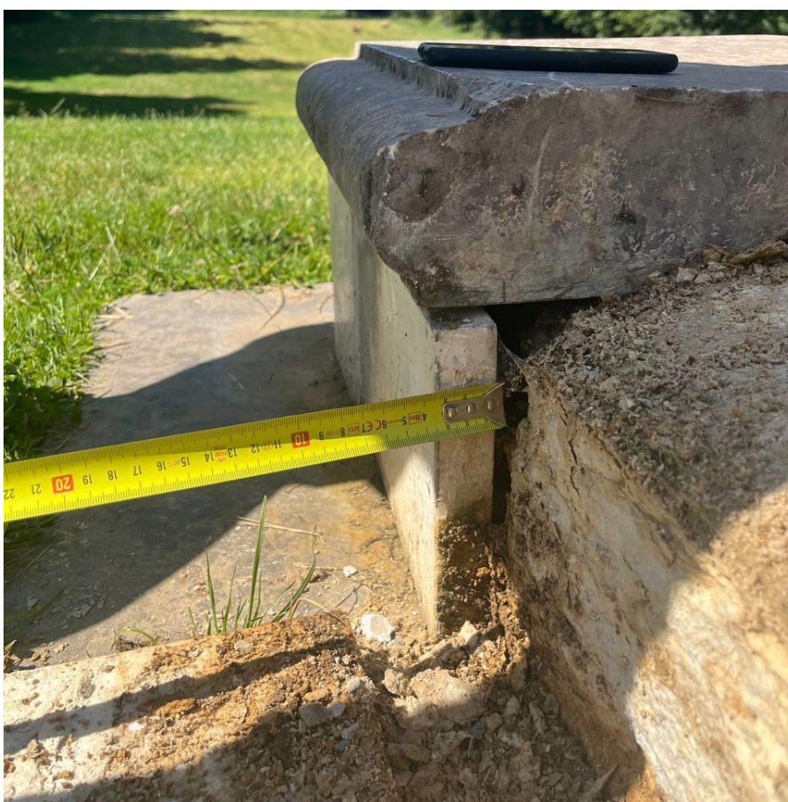
Fot. 4. Okładzina zewnętrzna po zdemontowaniu jej fragmentu
