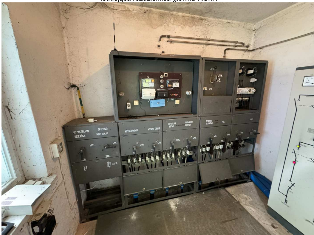
Istniejąca rozdzielnica główna RGnN
