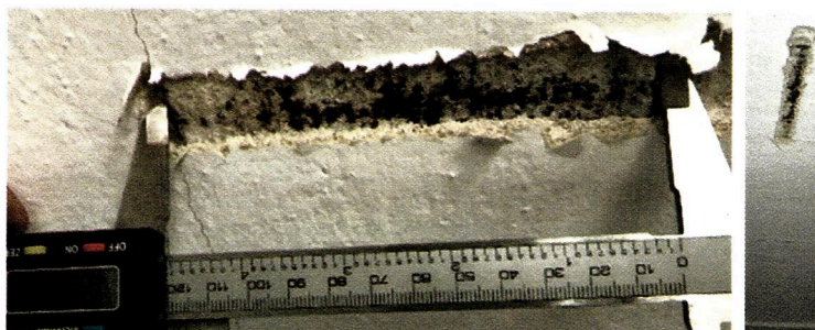
Fot. nr 29. Odkrywka nr 30 – Pomiar szerokości półki
