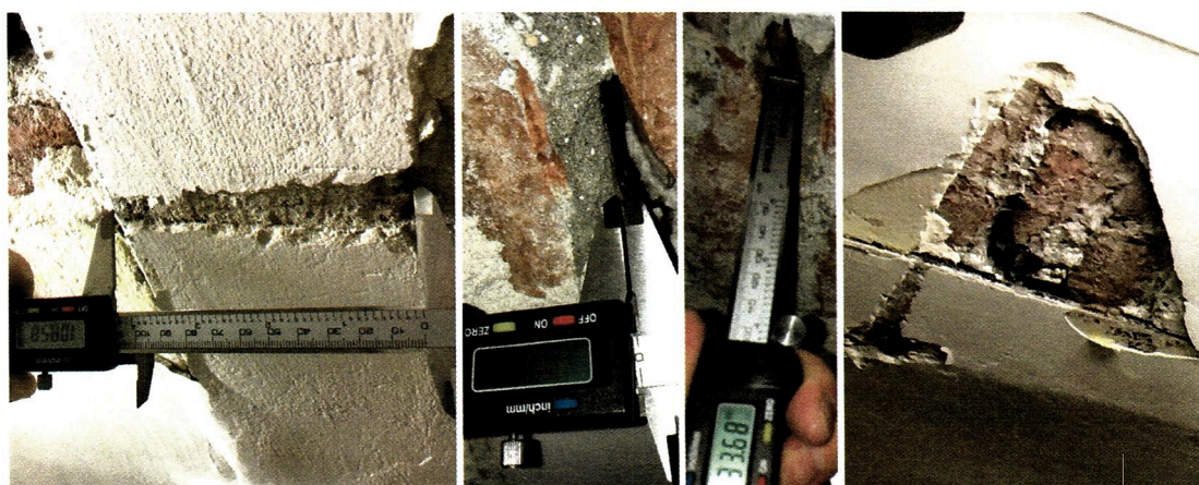
Fot. nr 10. Odkrywka nr 7 – Pomiar szerokości półki oraz grubości bednarki
