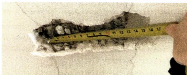
Fot. nr 30. Odkrywka nr 31 – Pomiar szerokości półki
