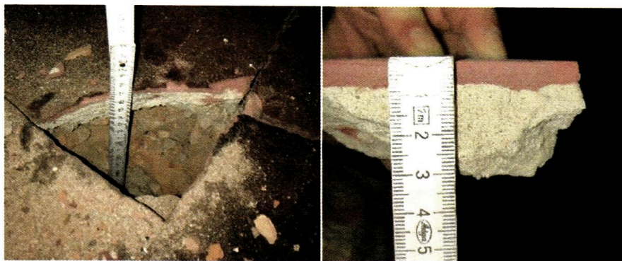
Odkrywka nr 14 – odkrywka warstw podłogowych w bibliotece
