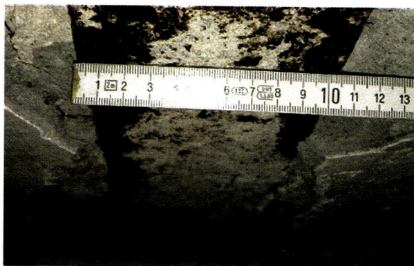
Fot. nr 7. Odkrywka nr 4 – pomiar szerokości półki
