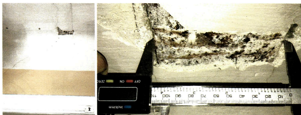
Fot. nr 16. Odkrywka nr 14 – Pomiar szerokości półki
