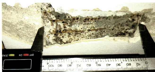
Fot. nr 11. Odkrywka nr 8 – Pomiar szerokości półki
