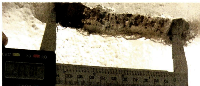
Fot. nr 27. Odkrywka nr 28 – Pomiar szerokości półki
