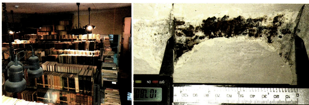
Fot. nr 15. Odkrywka nr 13 – Pomiar szerokości półki
