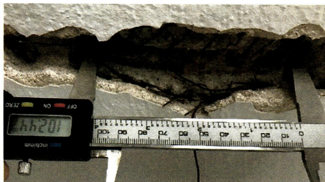
Fot. nr 21. Odkrywka nr 20 – Pomiar szerokości półki
