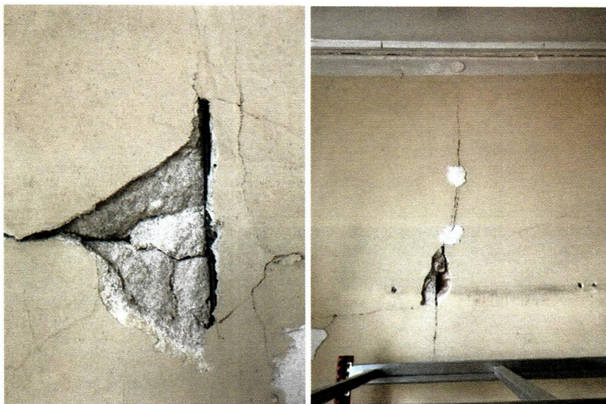
Fot. nr 31. Odkrywka nr 32 – odkrywki ściany murowanej V piętra
