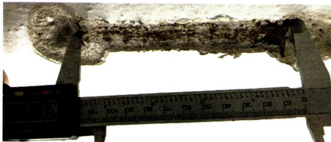
Fot. nr 28. Odkrywka nr 29 – Pomiar szerokości półki
