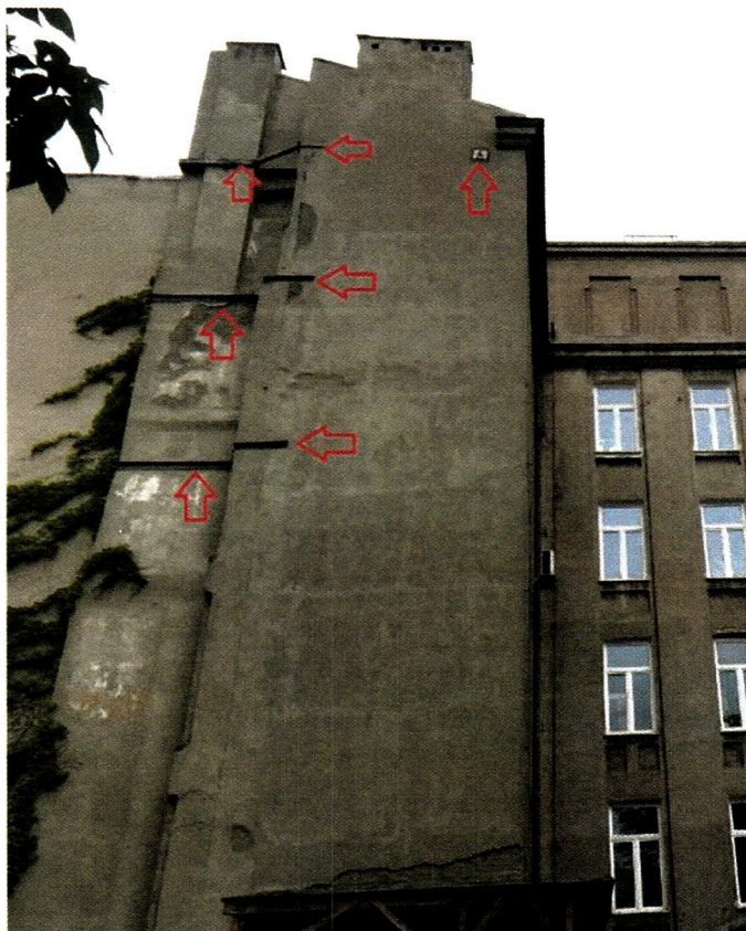
Fot. nr 3. Widok wzmocnień południowej ściany skrzydła zachodniego
