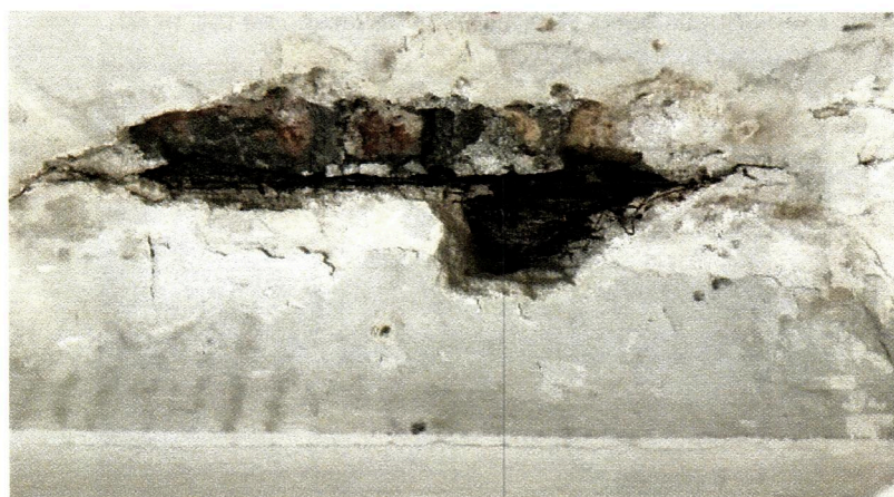
Fot. nr 32. Odkrywka nr 33 – odkrywka płyty ceglanej stropu na belce
