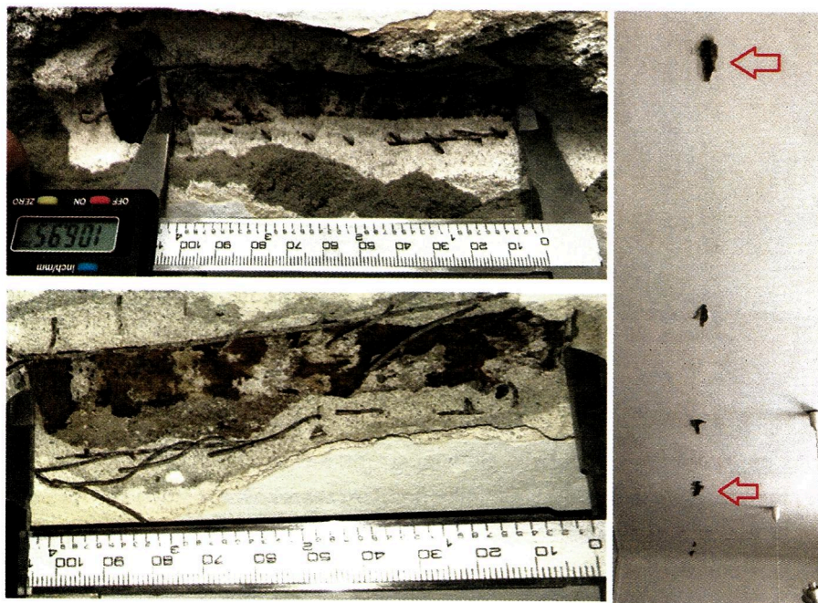
Fot. nr 23. Odkrywka nr 22 i 23 – Pomiar szerokości półki
