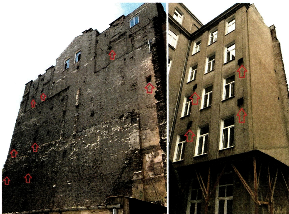
Fot. nr 2. Widok wzmocnień ścian wschodniej
