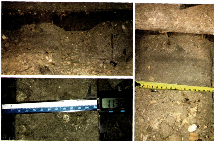
Fot. nr 33. Odkrywka nr 34 – Płyty ceglana półciężka stropu Kleina, Pomiar szerokości półki
