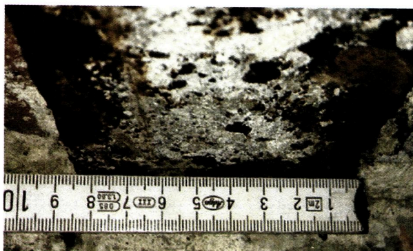
Fot. nr 6. Odkrywka nr 3 – pomiar szerokości półki
