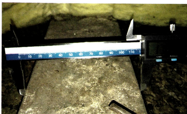
Fot. nr 34. Odkrywka nr 35 – Pomiar szerokości półki
