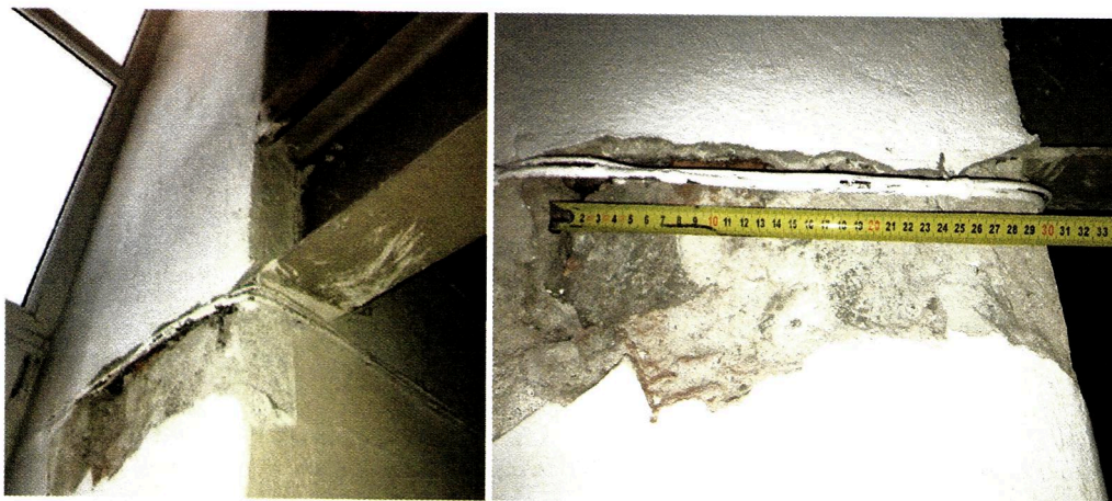
Fot. nr 13. Odkrywka nr 11 – oparcie belki antresoli na ścianie nośnej
