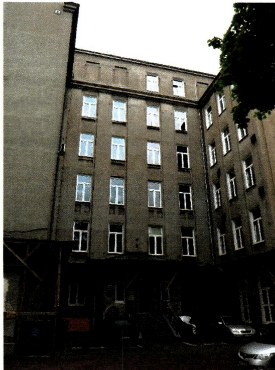
Fot. nr 1. Widok budynku od strony ul. Wilczej
