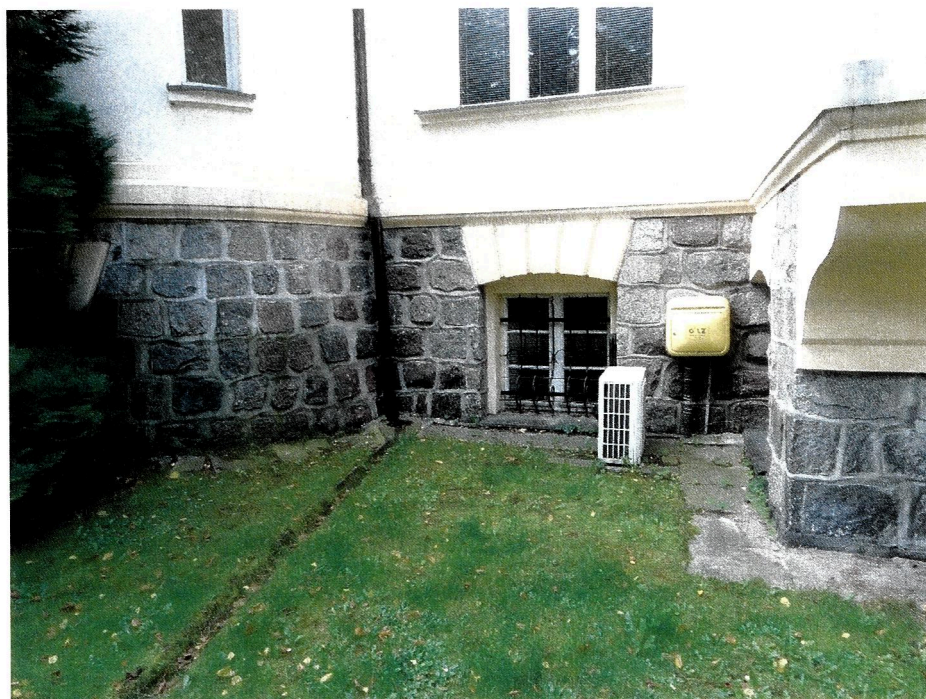
Fot.4. Elewacja południowo-wschodnia. Odprowadzenie wody opadowej.
