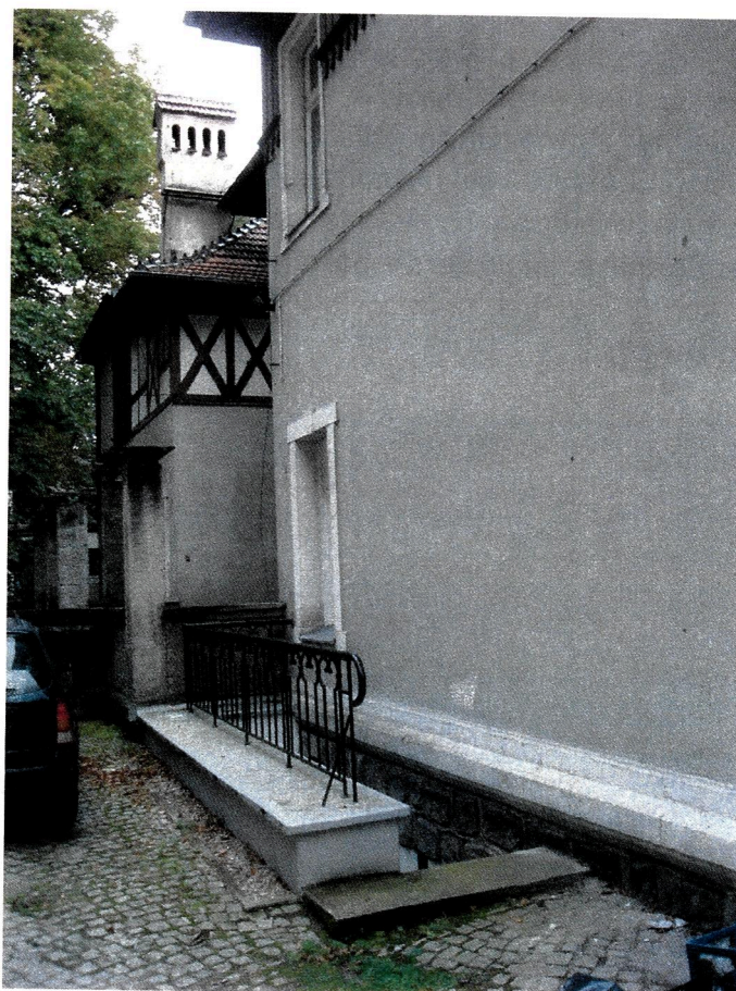
Fot.6. Schody zewn. do piwnicy na elewacji północno-zachodniej.
