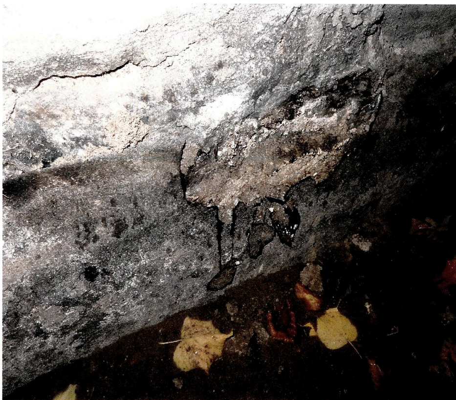
Fot.16. Izolacja pionowa na ścianie południowo-wschodniej.
