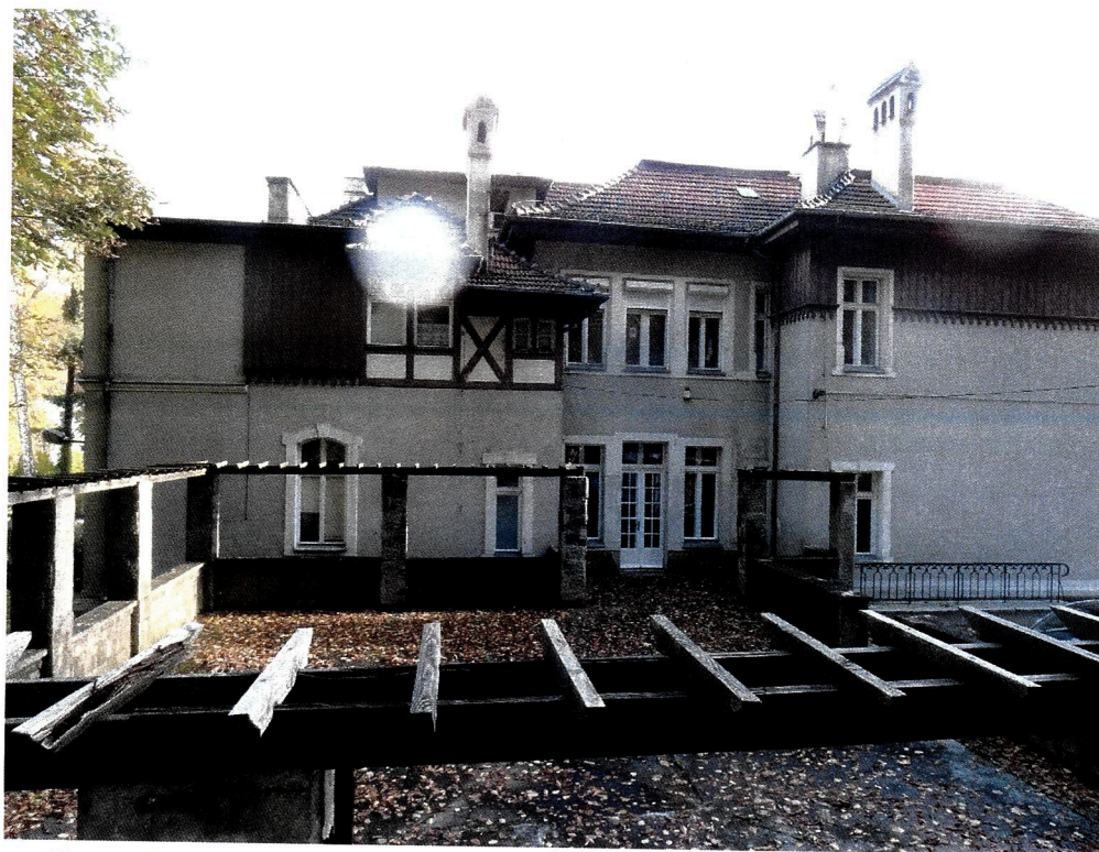
Fot.5. Elewacja północno-zachodnia. Taras, schody zewn. do piwnicy.
