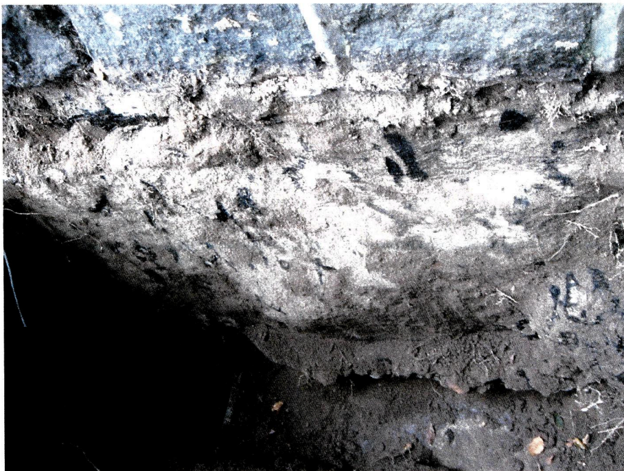
Fot.10. Odkrywka Nr 2 na elewacji północno-wschodniej.
