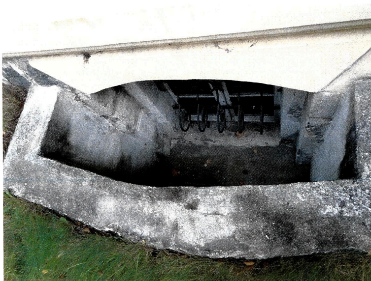
Fot.7. Studzienka doświetlająca na elewacji południowo-zachodniej.
