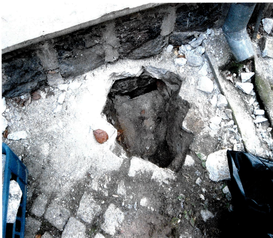
Fot.11. Odkrywka Nr 3 na elewacji północno-zachodniej.
