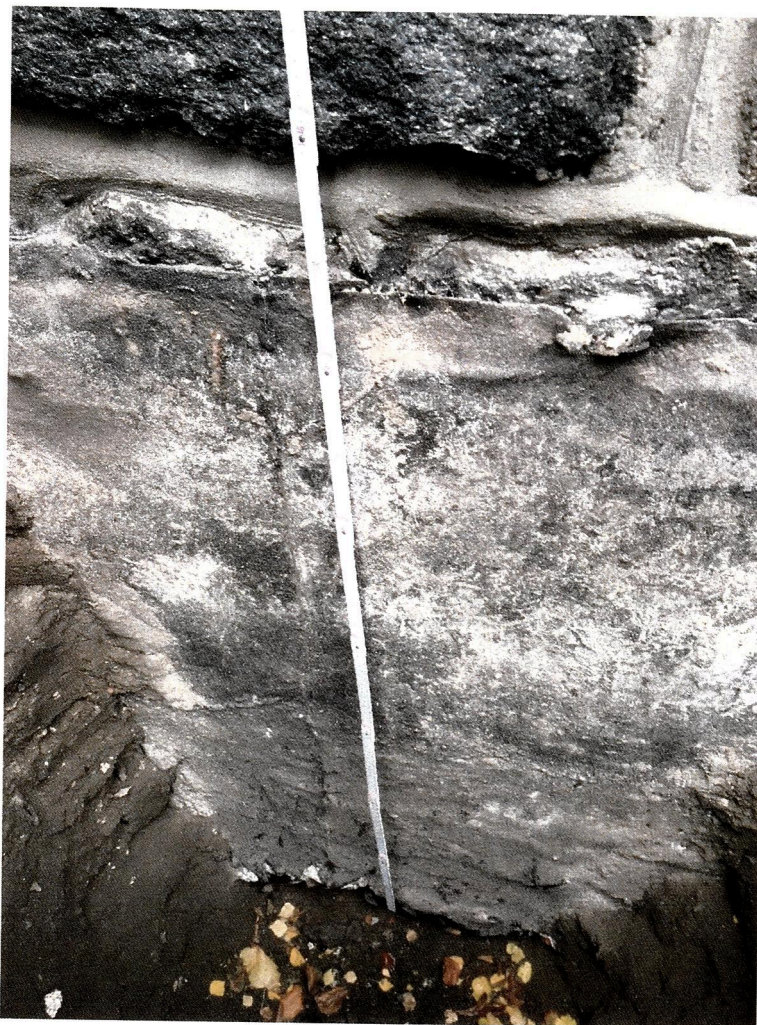
Fot.9. Odkrywka Nr 1 na elewacji południowo-wschodniej.
