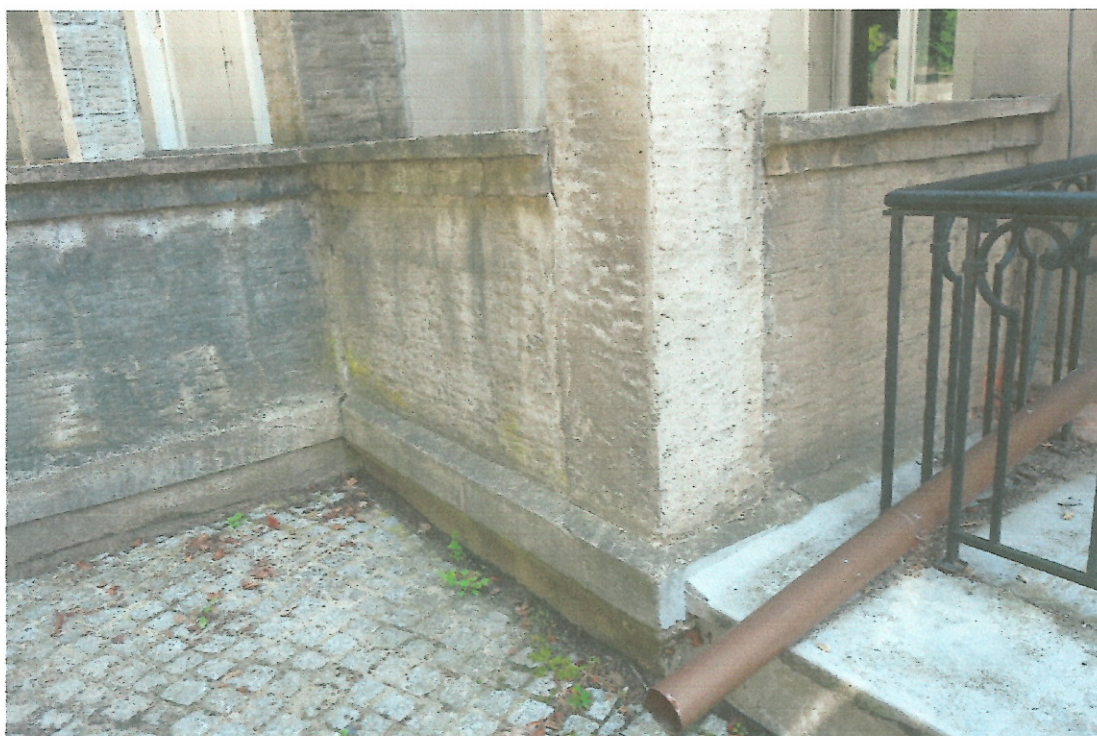
Fragment po stronie pd. zach., widoczne połączenie z elewacją
