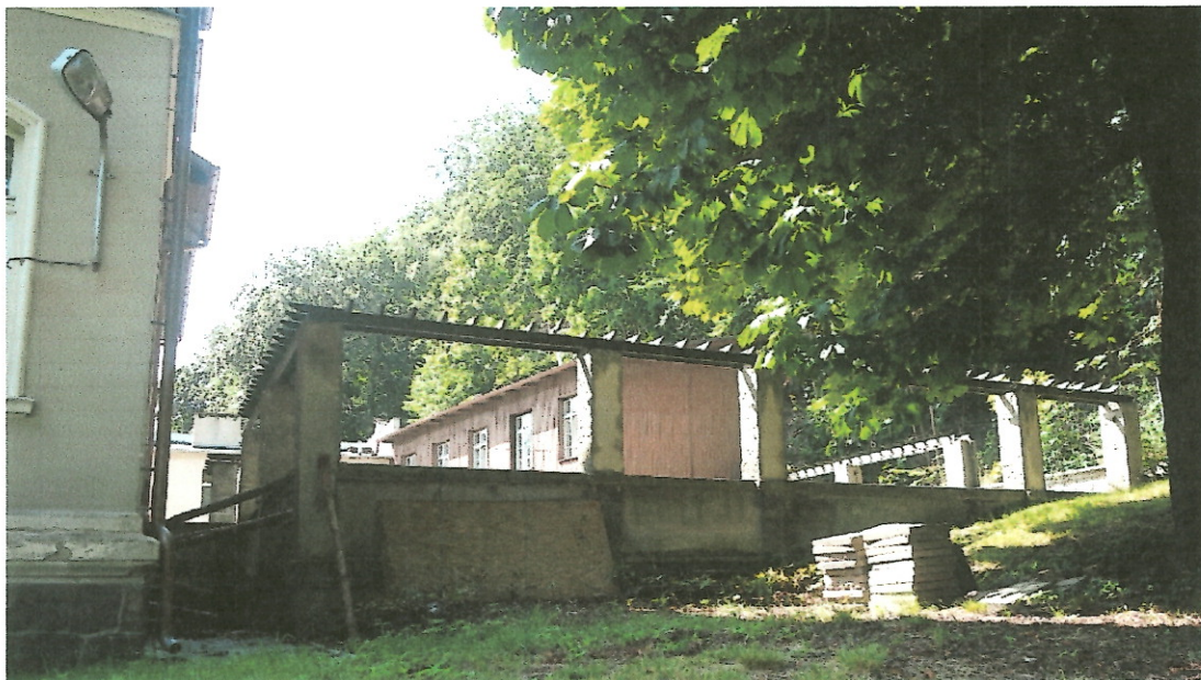
Widok na taras od strony elewacji wschodniej
