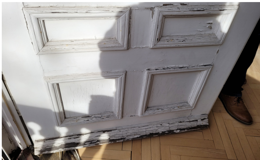
fot. 90. Ościeżce okienne nr 21 Uszkodzone drzwi balkonowe - widoczne popękane warstwy malarskie oraz porażone mikrobiologicznie drewno. marzec 2021 rok. fot. M. Caban
