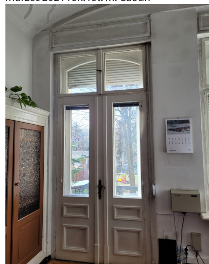
fot. 80. Ościeżce balkonowe nr 15 (widziane od wewnątrz), po wykonaniu odkrywek schodkowych osłonięto oryginalną zieloną i złotą warstwę malarską, marzec 2021 rok. fot. M. Caban
