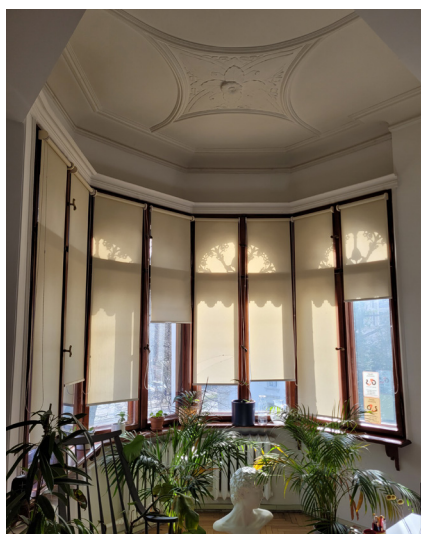
fot. 68. Ościerze okienne i balkonowe nr 9 (widziane od wewnątrz), wszystkie warstwy malarskie zostały usunięte, stolarkę pomalowano lakieroboją. marzec 2021 rok. fot. M. Caban
