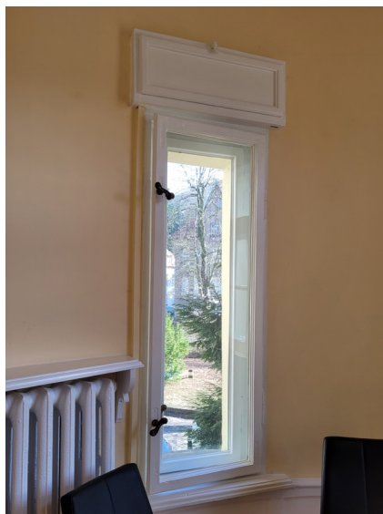
fot. 62. Ościerze okienne nr 2 (widziane od wewnątrz), wszystkie warstwy malarskie zostały usunięte, stolarkę pomalowano wtórnie na biało. marzec 2021 rok. fot. M. Caban
