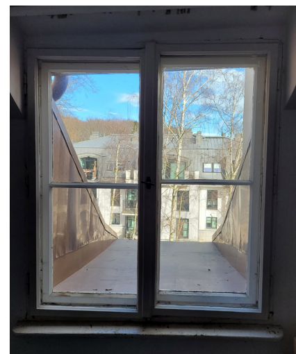
fot. 106. Ościeżce okienne nr 42 (widziane od wewnątrz), stolarka wtórnie przemalowana na biało, zamontowane parapety metalowe tytan - cynk. marzec 2021 rok. fot. M. Caban
