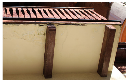
fot. 32, 33, 34. Brak izolacji oraz swobodne przenikanie wody spowodowało trwałe uszkodzenie balkonu, dezintegrację tynku, wykwity solne, łuszczenie się farb oraz silne skażenie mikrobiologiczne, marzec 2021. fot. M. Caban
