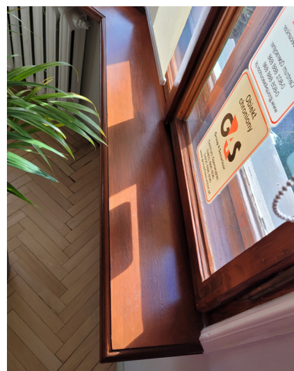
fot. 69. Ościerze okienne i balkonowe nr 9 (widziane od wewnątrz), wszystkie warstwy malarskie zostały usunięte, stolarkę pomalowano lakieroboją. marzec 2021 rok. fot. M. Caban
