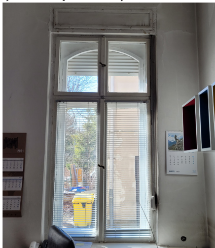
fot. 70. Ościeżce okienne nr 12 (widziane od wewnątrz), po wykonaniu odkrywek schodkowych osłonięto oryginalną zieloną warstwę malarską. marzec 2021 rok. fot. M. Caban
