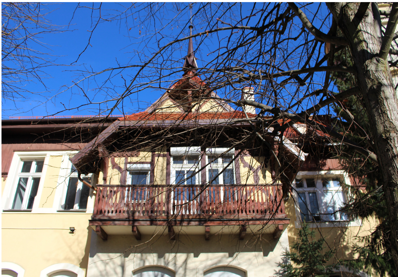
fot. 16. Elewacja boczna, balkon po wojnie przerobiony z pierwotnego drewnianego tarasu. fot. M. Caban, marzec 2021
