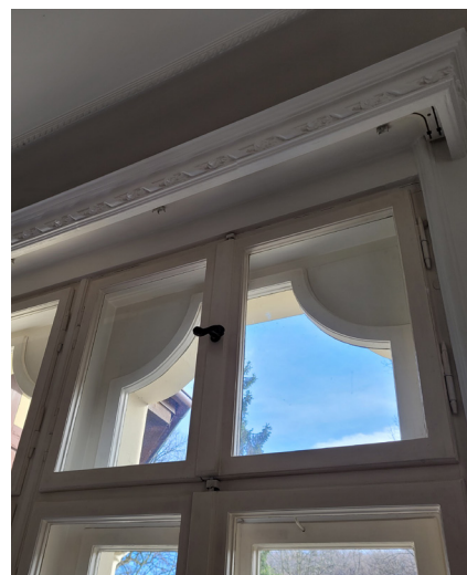
fot. 66. Ościerze okienne nr 7 (widziane od wewnątrz), wszystkie warstwy malarskie zostały usunięte, stolarkę pomalowano wtórnie na biało. marzec 2021 rok. fot. M. Caban
