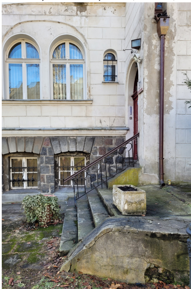
fot. 22. Elewacja boczna, betonowe schody wejścia głównego. fot. M. Caban, marzec 2021
