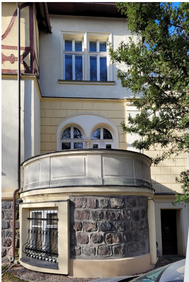
fot. 13. Taras elewacji frontowej - fot. M. Caban, marzec 2021
