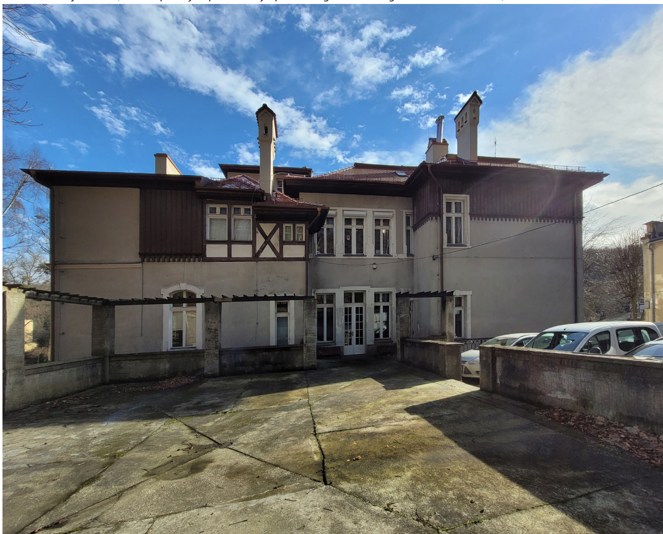
fot. 17. Elewacja tylna, fot. M. Caban, marzec 2021
