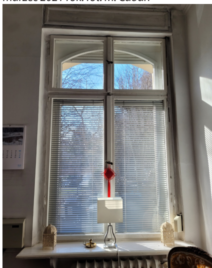
fot. 71. Ościeżce balkonowe nr 14 (widziane od wewnątrz), po wykonaniu odkrywek schodkowych osłonięto oryginalną zieloną warstwę malarską. marzec 2021 rok. fot. M. Caban
