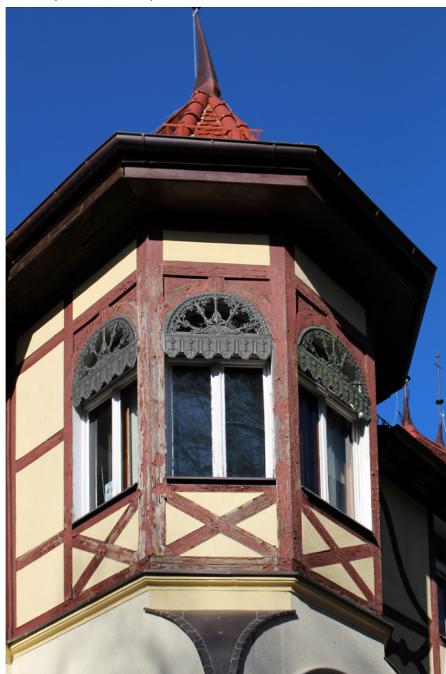
fot. 12. Wykusze - na oknach widoczne oryginalne metalowe zdobienia okien, przy zielonkawej stolarnie stanowiły spoiste obramienie ościeży. fot. M. Caban, marzec 2021
