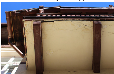
fot. 32, 33, 34. Brak izolacji oraz swobodne przenikanie wody spowodowało trwałe uszkodzenie balkonu, dezintegrację tynku, wykwity solne, łuszczenie się farb oraz silne skażenie mikrobiologiczne, marzec 2021. fot. M. Caban
