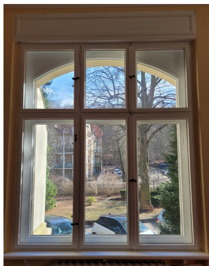
fot. 56. Ościeżce okienne nr 5 (widziane od wewnątrz), wszystkie warstwy malarskie zostały usunięte, stolarkę pomalowano wtórnie na biało. marzec 2021 rok. fot. M. Caban
