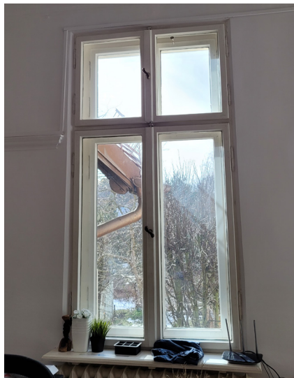
fot. 96. Ościeżce okienne nr 19 (widziane od wewnątrz), wszystkie warstwy malarskie zostały usunięte, stolarkę pomalowano wtórnie na biało. marzec 2021 rok. fot. M. Caban
