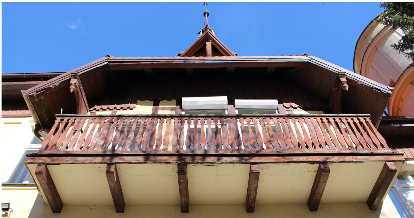
fot. 31. Balkon elewacji bocznej, pierwotnie stanowił, marzec 2021 rok. fot. M. Caban
