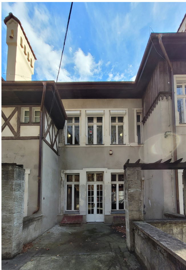
fot. 18. Elewacja tylna willi - widoczne ościeża okienne sali konferencyjnej oraz oryginalne odeskowanie elewacji. fot. M. Caban, marzec 2021
