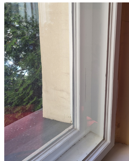
fot. 57. Ościeżce okienne nr 3 (widziane od wewnątrz), stolarka wtórnie przemalowana na biało, zamontowane parapety metalowe tytan - cynk. marzec 2021 rok. fot. M. Caban
