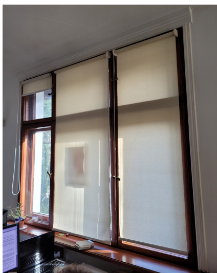
fot. 67. Ościerze okienne i balkonowe nr 10 (widziane od wewnątrz), wszystkie warstwy malarskie zostały usunięte, stolarkę pomalowano lakieroboją. marzec 2021 rok. fot. M. Caban
