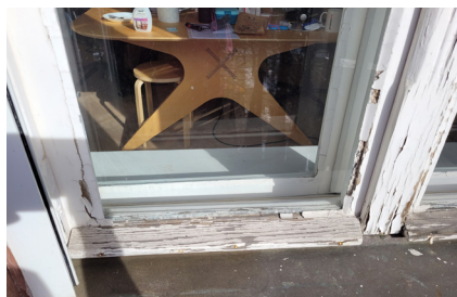
fot. 90. Ościeżce okienne nr 21 Uszkodzone drzwi balkonowe - widoczne popękane warstwy malarskie oraz porażone mikrobiologicznie drewno. marzec 2021 rok. fot. M. Caban
