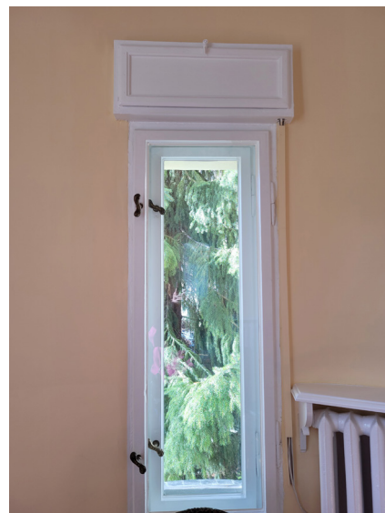
fot. 63. Ościerze okienne nr 1 (widziane od wewnątrz), wszystkie warstwy malarskie zostały usunięte, stolarkę pomalowano wtórnie na biało. marzec 2021 rok. fot. M. Caban
