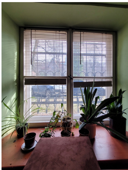
fot. 119. Ościerze okienne P4 (widziane od wewnątrz), stolarkę pomalowano wtórnie na białą, zachowały się oryginalne ozdobne klamki. marzec 2021 rok. fot. M. Caban
