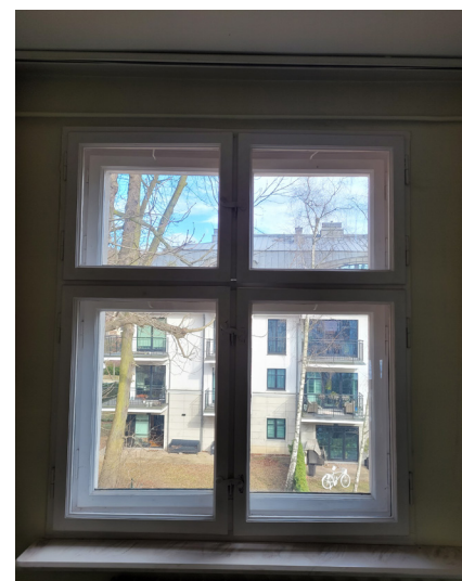
fot. 109. Ościeżce okienne nr 40 (widziane od wewnątrz), stolarka wtórnie przemalowana na biało, zamontowane parapety metalowe tytan - cynk. marzec 2021 rok. fot. M. Caban
