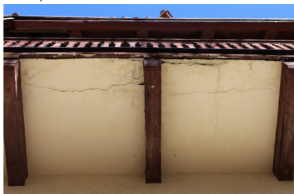
fot. 32, 33, 34. Brak izolacji oraz swobodne przenikanie wody spowodowało trwałe uszkodzenie balkonu, dezintegrację tynku, wykwity solne, łuszczenie się farb oraz silne skażenie mikrobiologiczne, marzec 2021. fot. M. Caban
