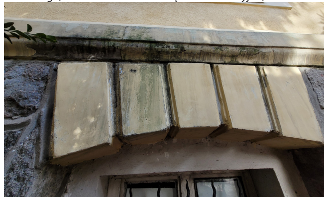
fot. 30. Dezintegracja tynku, wykwyty solne, złuszczenie się farb oraz silne skażenie mikrobiologiczne, marzec 2021, fot. M. Caban
