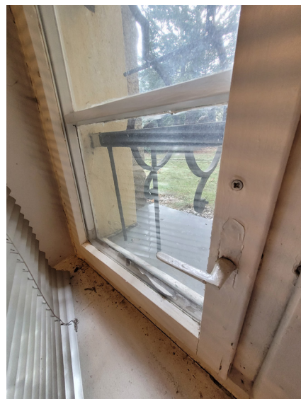
fot. 121. Ościerze okienne nr P5 Okno prawdopodobnie wtórne z lat 80, stan okna zły, stolarka pomalowana na białą. marzec 2021 rok. fot. M. Caban
