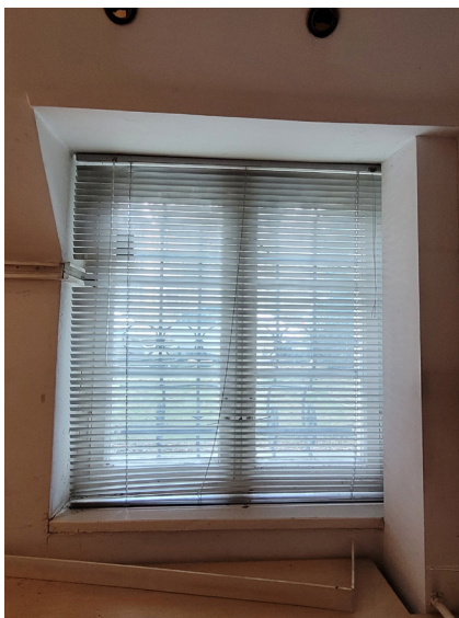
fot. 120. Ościerze okienne P5 (widziane od wewnątrz), stolarkę pomalowano wtórnie na białą, zachowały się oryginalne ozdobne klamki. marzec 2021 rok. fot. M. Caban
