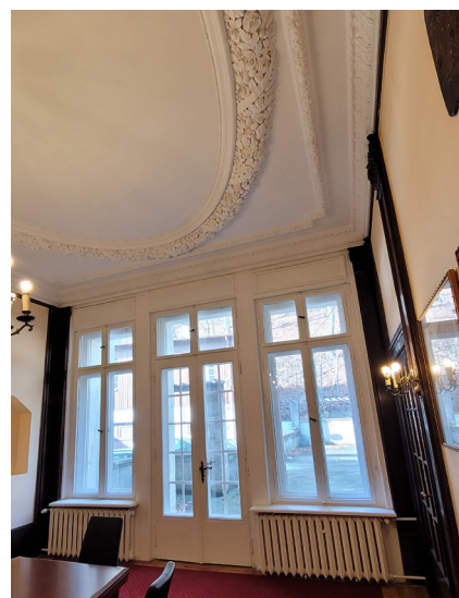
fot. 103. Ościeżce okienne nr 25 (widziane od wewnątrz), wszystkie warstwy malarskie zostały usunięte, stolarkę pomalowano wtórnie na biało. marzec 2021 rok. fot. M. Caban
