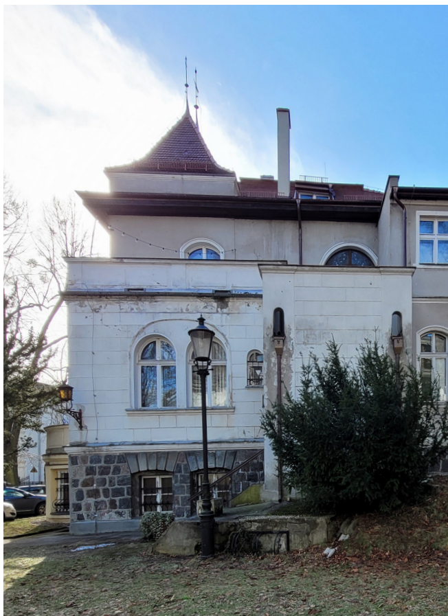
fot. 49. Taras elewacji bocznej, marzec 2021 rok. fot. M. Caban
