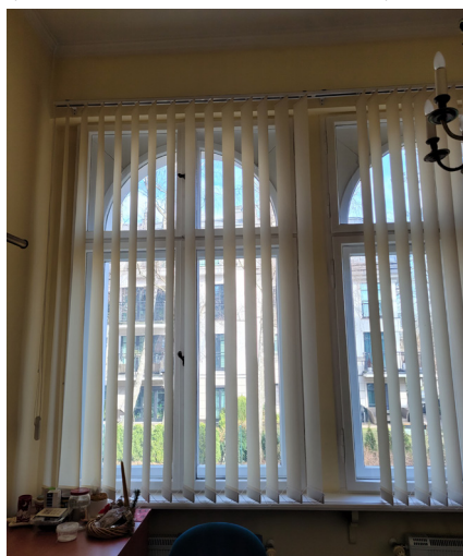
fot. 104. Ościeżce okienne nr 33 (widziane od wewnątrz), wszystkie warstwy malarskie zostały usunięte, stolarkę pomalowano wtórnie na biało. marzec 2021 rok. fot. M. Caban
