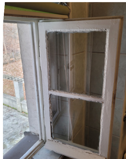
fot. 100. Ościeżce okienne nr 28 wszystkie warstwy malarskie zostały usunięte, stolarkę pomalowano wtórnie na biało marzec 2021 rok. fot. M. Caban
