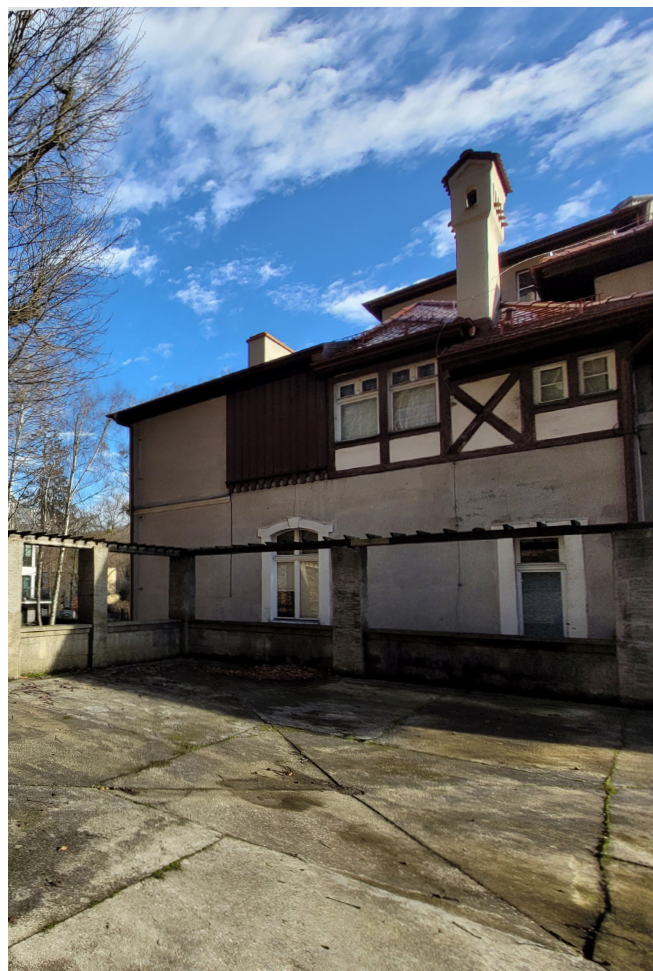
fot. 19. Elewacja tylna willi. Widoczny fragment pergoli oraz tarasu. fot. M. Caban, marzec 2021
