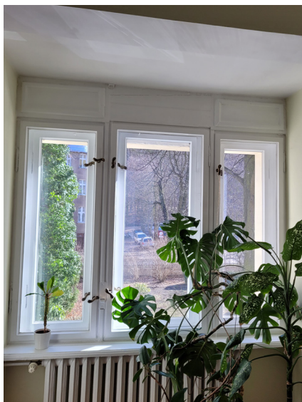
fot. 61. Ościerze okienne nr 4 (widziane od wewnątrz), wszystkie warstwy malarskie zostały usunięte, stolarkę pomalowano wtórnie na biało. marzec 2021 rok. fot. M. Caban
