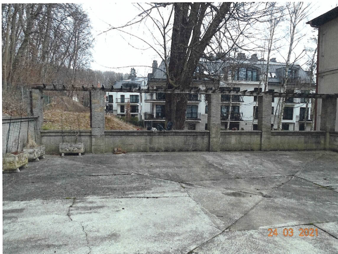
Widok płyty tarasowej z południowo-zachodniego
