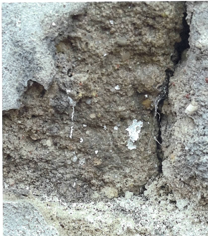
Odsłonięty fragment muru obwodowego
