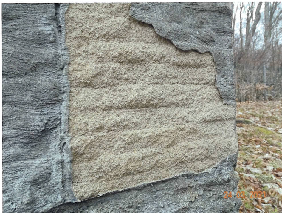
Zbliżenie okładziny muru obwodowego i filarów
