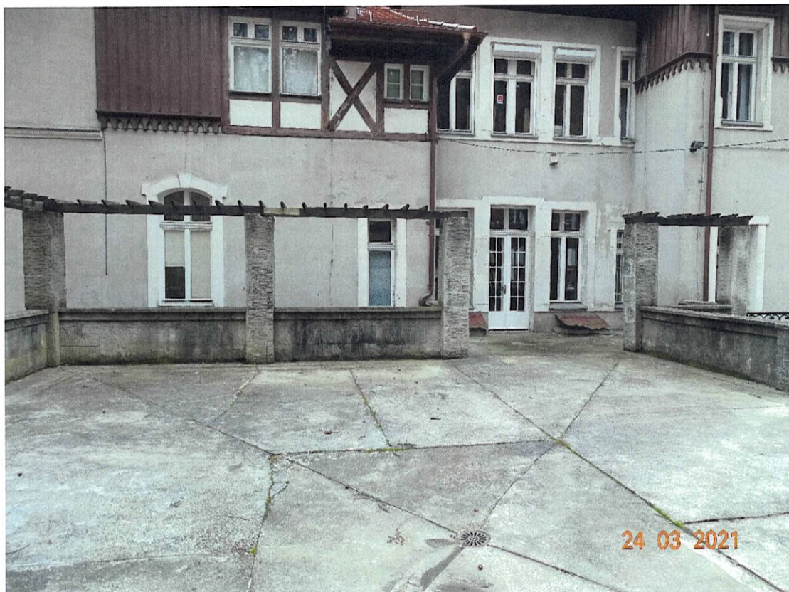
Aktualny widok tarasu z kierunku północno-wschodniego
