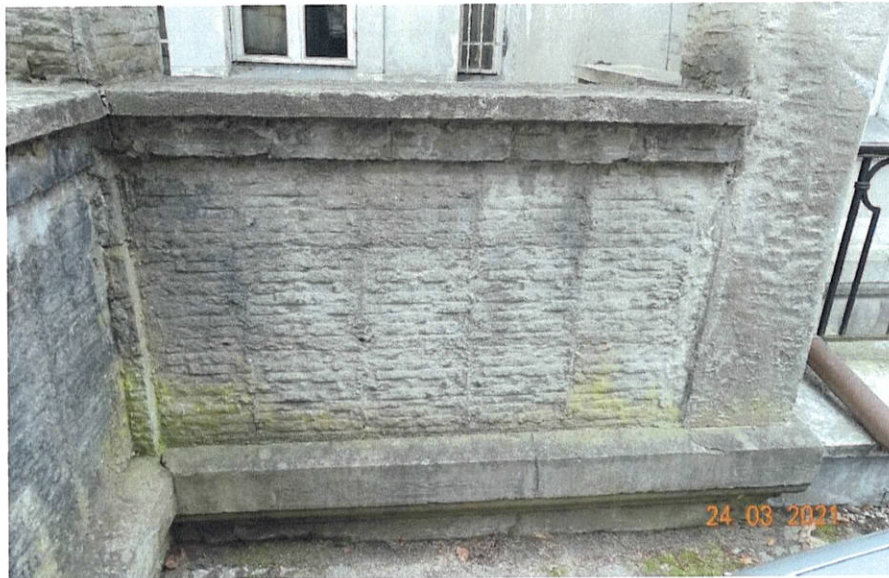
Przykładowy widok zewnętrznego gzymsu płyty podłogowej tarasu
