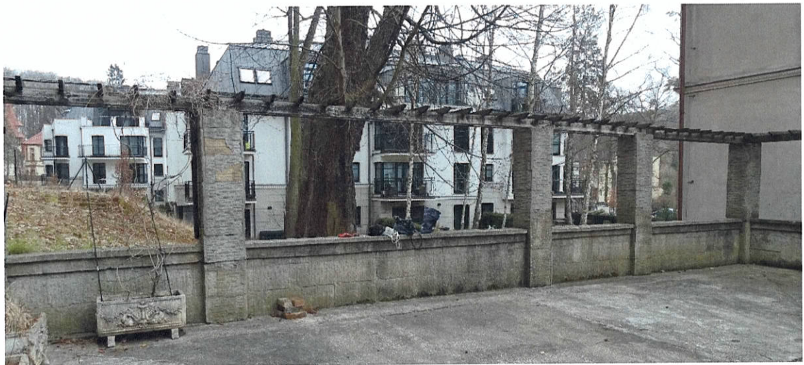
Przykładowy widok filarów z pergolą płn.-wsch. odcinka muru obwodowego
